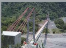
屏東霧台古仁人吊橋
