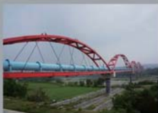
新竹寶山水管橋
