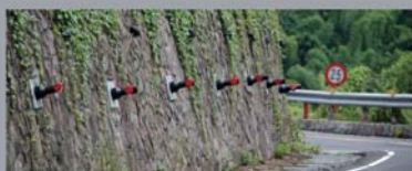
藤枝林道崩塌地滑區第一期整治工程
