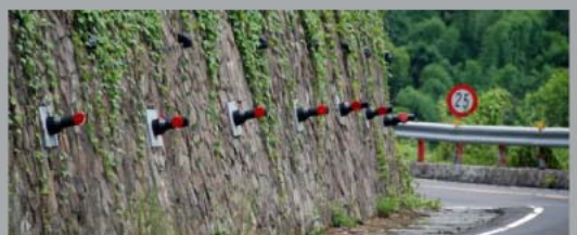
藤枝林邊崩塌地滑區第一期整治工程
