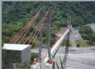
屏東霧台古仁人吊橋
