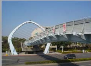
南科東入口行人陸橋
