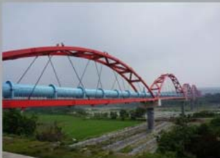
新竹寶山水管橋
